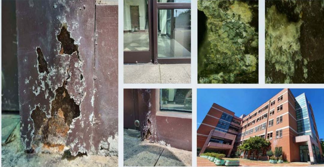
(a), (b) 알루미늄 문 부식 부분 광학현미경 사진
